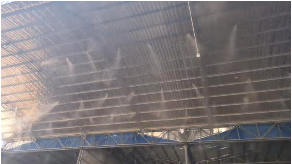
砂石料棚顶部防尘喷雾装置
